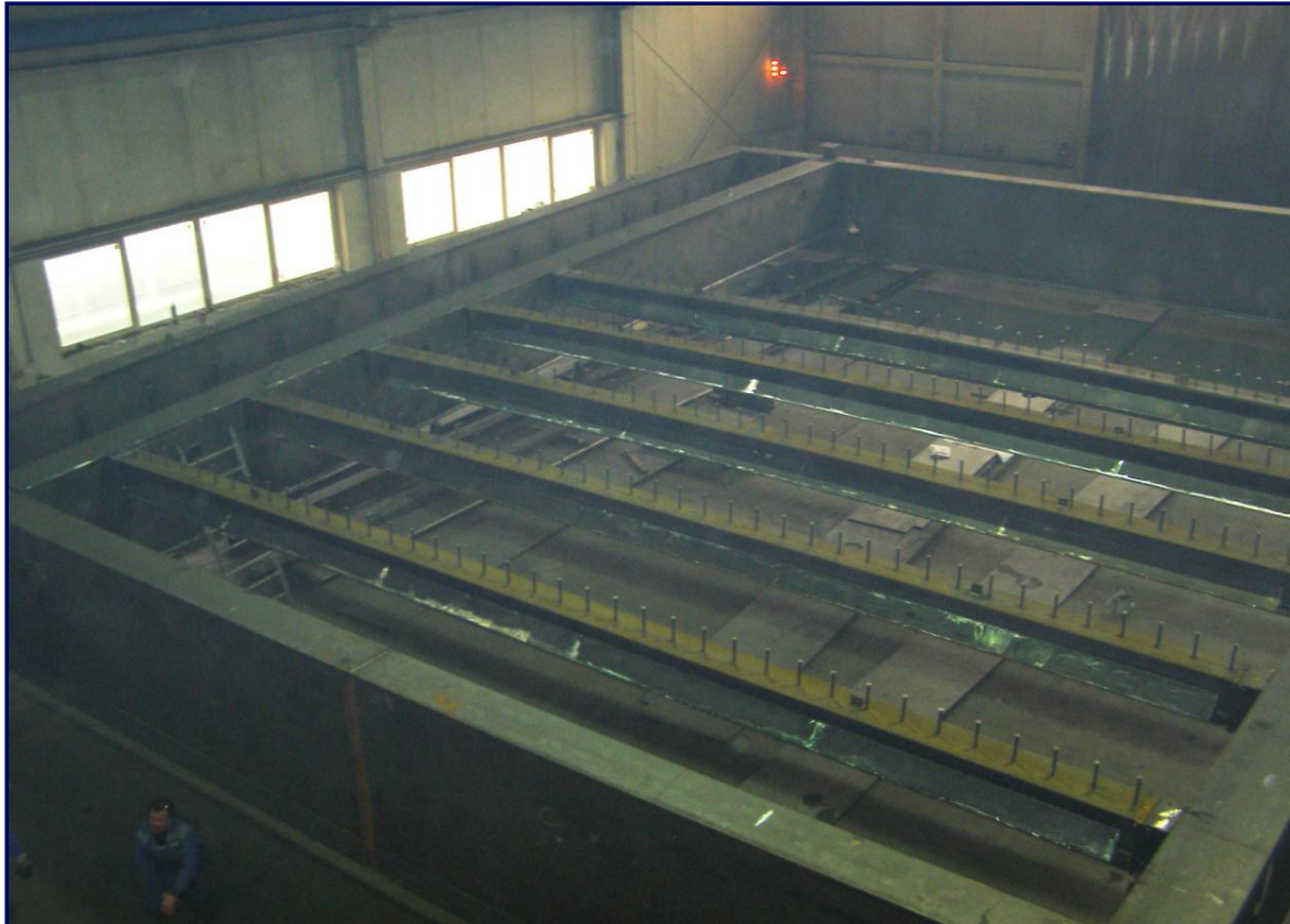
Berlin Ostkreuz Bahnsteigbrücken
